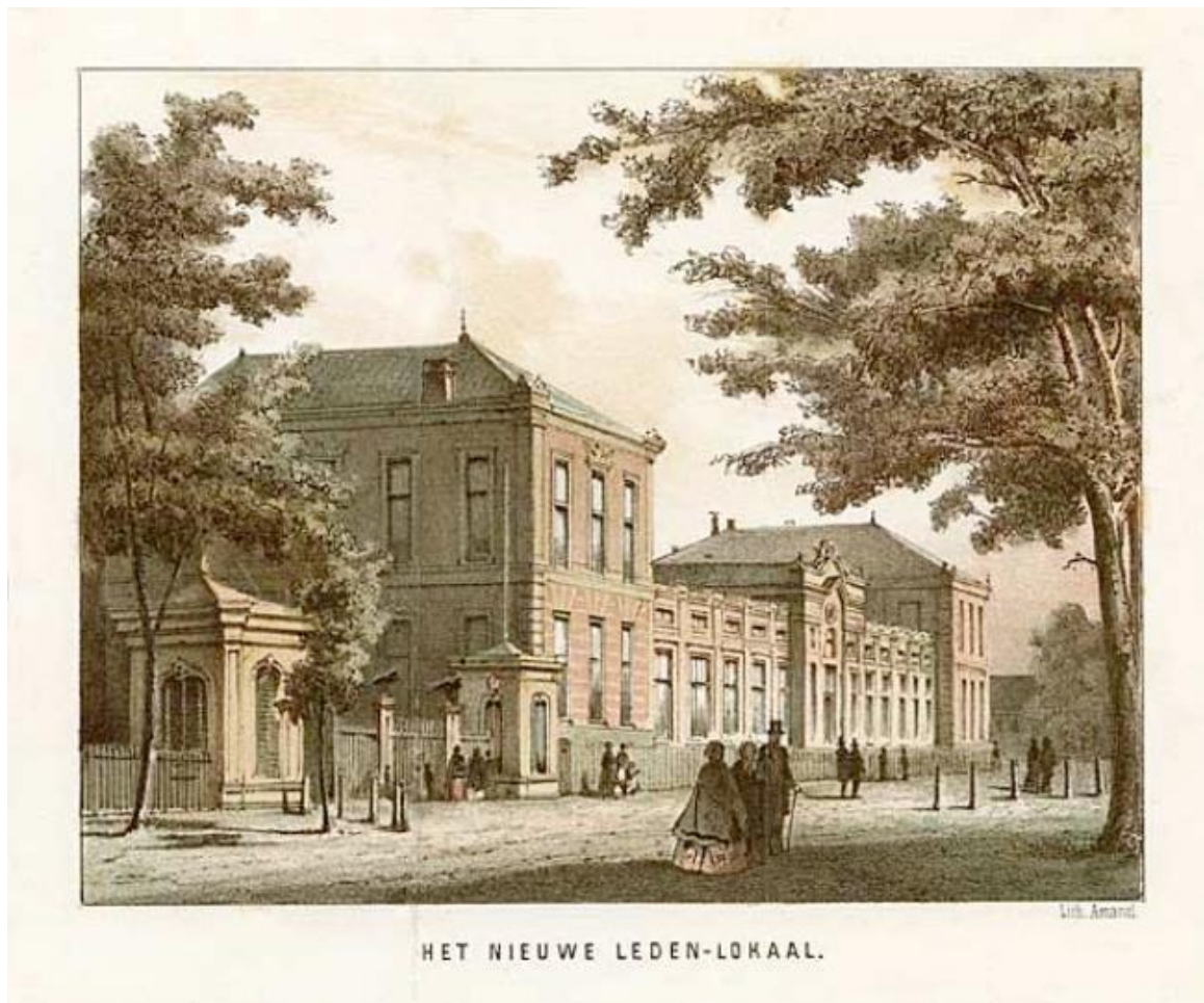
Het complex van Artis aan de Plantage Kerklaan. Links de toegang tot het park. Tussen de twee gebouwen met een verdieping bevond zich de ‘concertzaal’.
